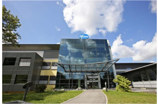
Foto: Pfizer Betriebsstätte Freiburg
